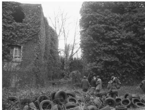
Les ruines de la cartonnerie Jacquet seront démolies.
