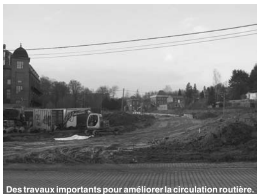
Des travaux importants pour améliorer la circulation routière.
